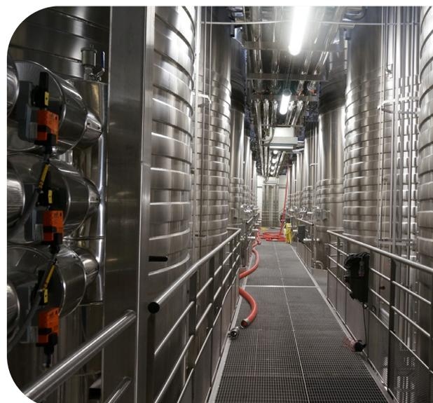
L'architecture de développement est basée sur les objets PcVue, ce qui a grandement facilité la conception du logiciel de supervision. Étant donné que les caves de fermentation de Veuve Clicquot contiennent 400 cuves de différents types et volumes allant jusqu'à 60 000 litres (16 000 gallons), les développeurs devaient pouvoir utiliser des modèles pour réduire les temps de programmation et de maintenance.
